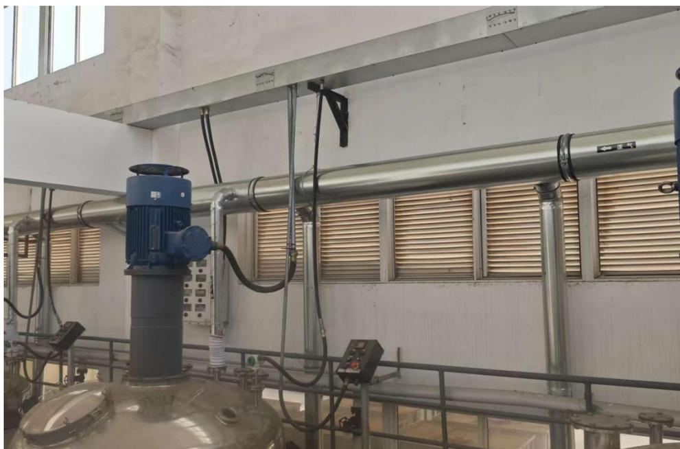
图 4.1-2 车间废气收集
