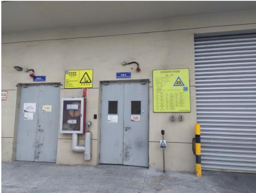
图3-4.1 危险废物仓库
